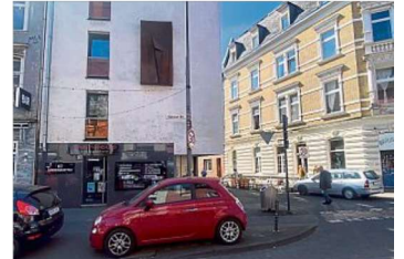
Heute steht auf dem Eckgrundstück ein Wohn- und Geschäftshaus. Foto: Ayhan Demirci
